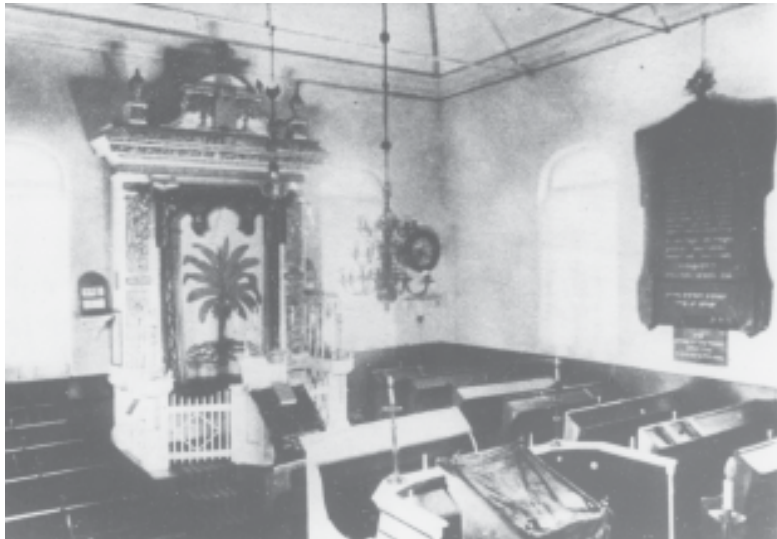
Inneres der 1810 erbauten Synagoge von Aurich. Das Foto wurde bald nach 1914 aufgenommen.
